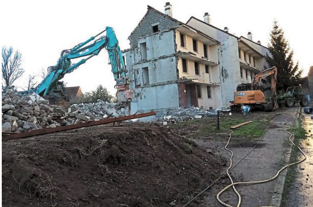
Dernière phase de démolition pour les vingt-quatre logements sociaux résidence Chemin des Près.
