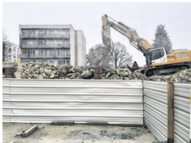
Les démolitions d'immeubles se poursuivent à Hauteville.
